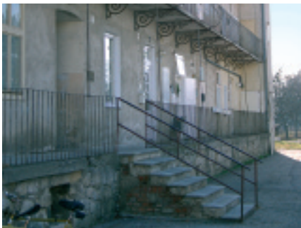
Sanierungsobjekt Wr. Neustädter Str. 10
