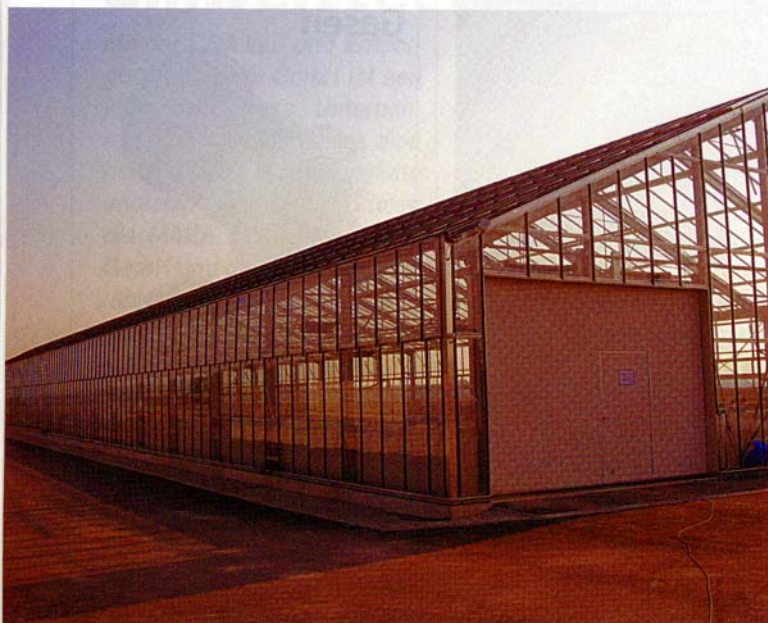
Solare Schlamm-trocknung auf der Kläranlage Ebreichsdorf.
